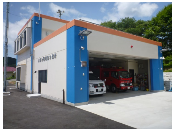
【消防庁舎復旧事業】 大船渡地区消防組合大船渡消防署 三陸分署綾里分遣所
