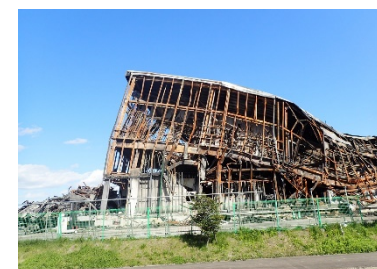
【R2.4月 宮城県岩沼市に おける倉庫火災】
