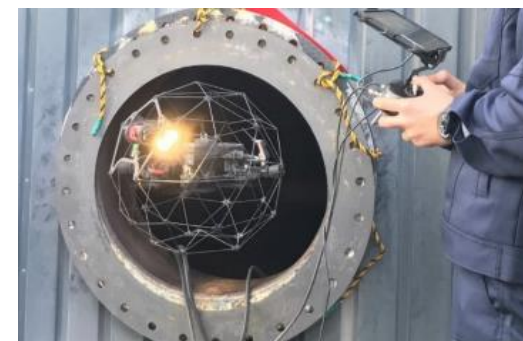
【デジタル技術を活用した効果的な予防保全の例 (ドローンを用いたタンク内部の点検)】
